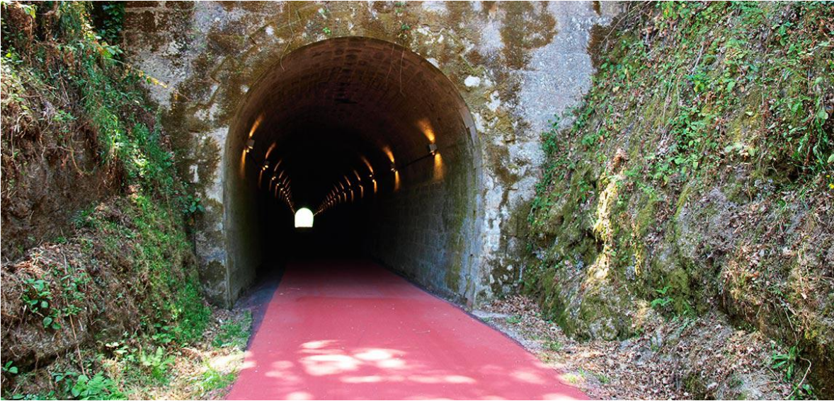
Figura 31. Túnel da Ecopista do Dão, que percorre a antiga Linha do Dão entre Santa Comba Dão e Viseu. A transformação das antigas linhas em Ecopistas permite a preservação dos ativos e do património ferroviário, mantendo-os ao serviço da sociedade e não fechando a possibilidade de voltarem a ter função ferroviária.
